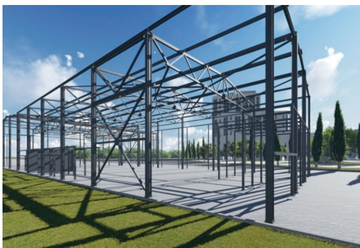
Крепление металлоконструкций к бетонному основанию
