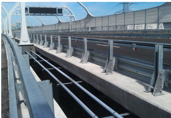
Крепление барьерного ограждения
