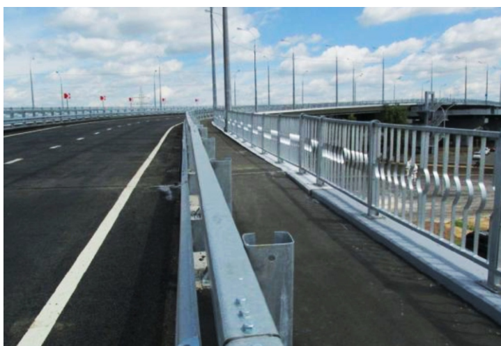
Крепление перильного ограждения
